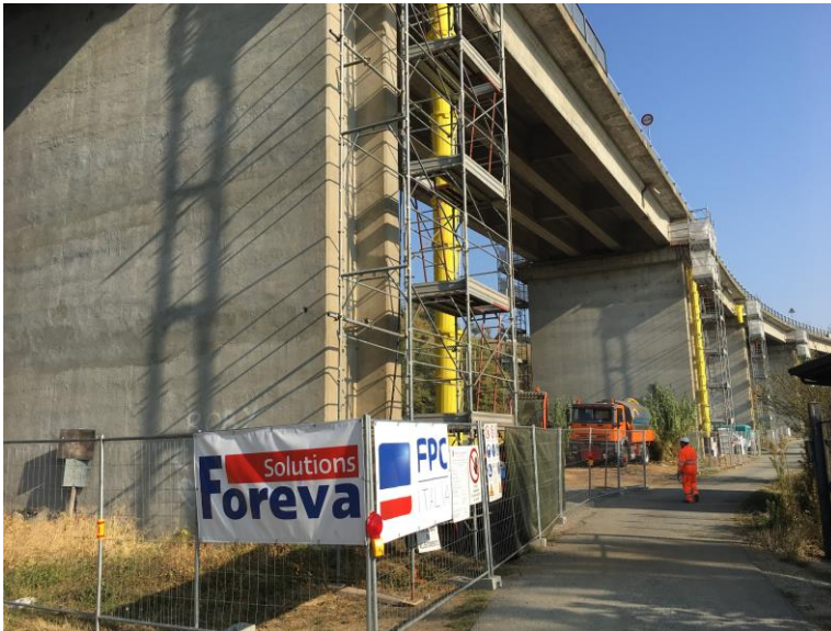
Post-tensione esterna per messa in sicurezza del viadotto
