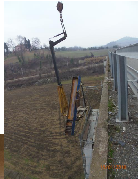
Post-tensione esterna per messa in sicurezza del viadotto
