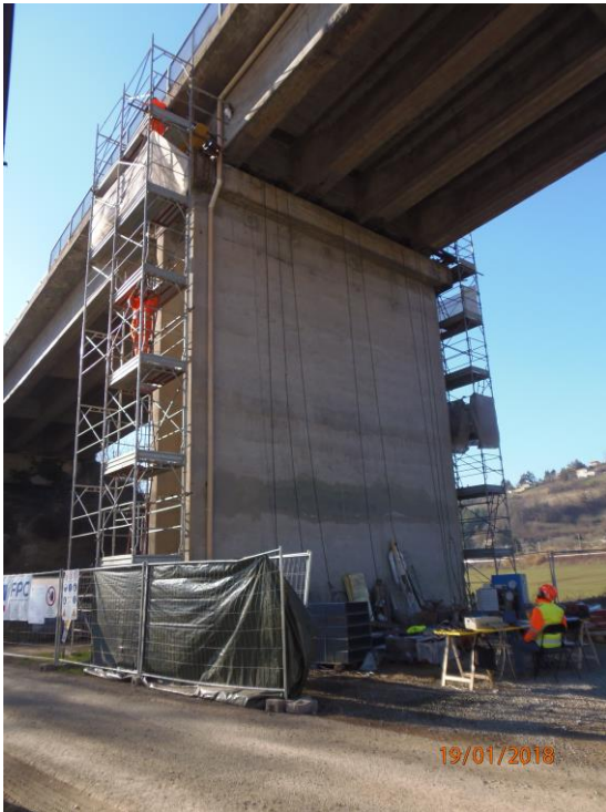
Sollevamento per operazioni di ripristino del cemento e dei ferri di armatura ammalorati
