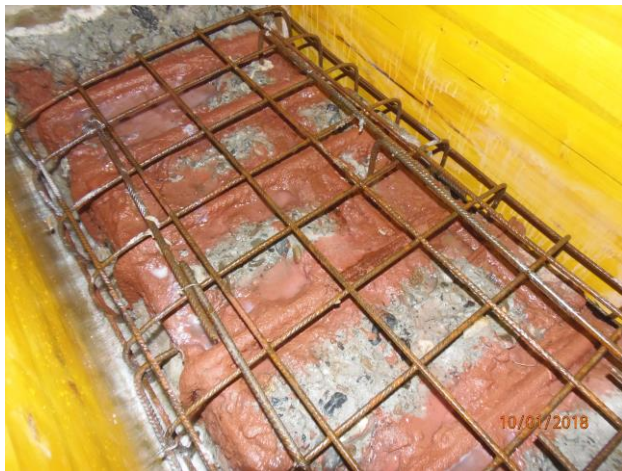
Preparazione per ripristino baggioli e piano per apparecchi d'appoggi
