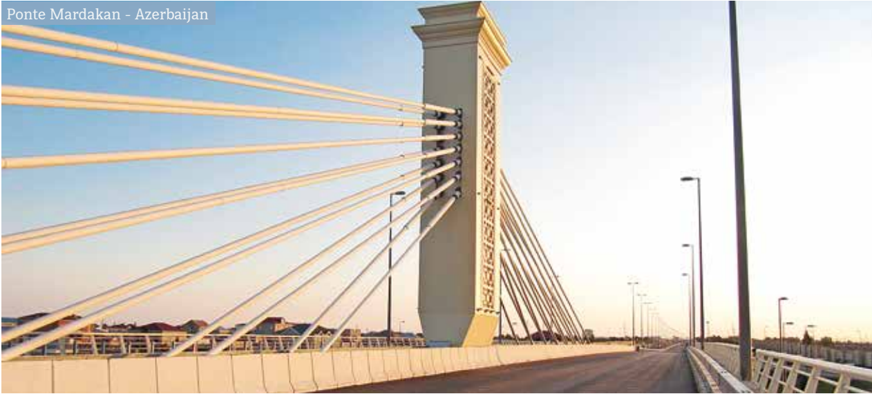
Ponte linea ferroviaria Birtouta Zeralda- Algeria
